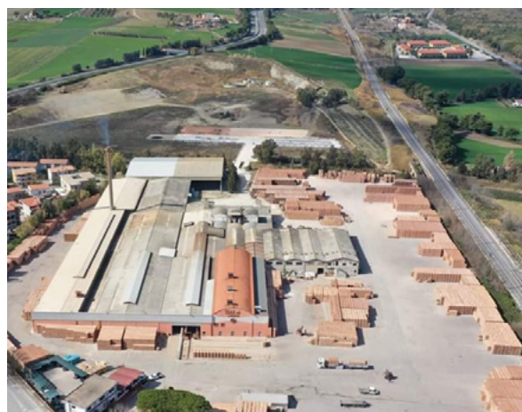
Vista aerea dello stabilimento
