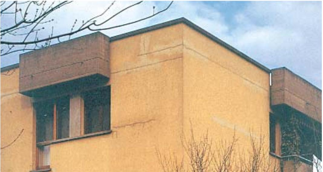
**Fessurazioni in corrispondenza del solaio piano di copertura causate dal ritiro della soletta e da un insufficiente isolamento termico.**
